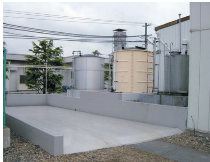
薬液タンクおよび防油堤(古川工場)
