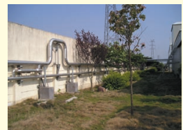
無錫アルプスの蒸気輸送管
