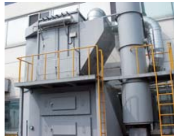
活性炭を用いた VOC 吸着塔（韓国アルプス）
