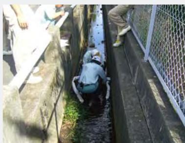
長岡工場(新潟県)にて、重油が漏洩したケースを想定し、対応手順・対策キットの作業性などを検証
