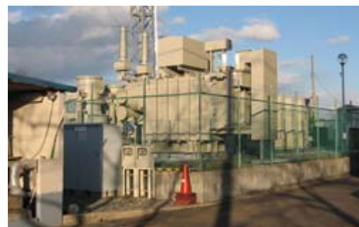
新たに稼働した特高変電所
