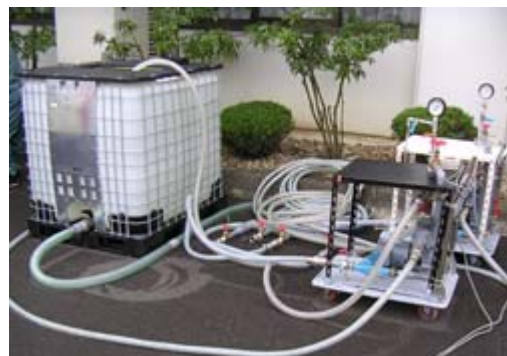
過去に涌谷工場(宮城県)で使用した、地下水に栄養剤を注入するための装置
