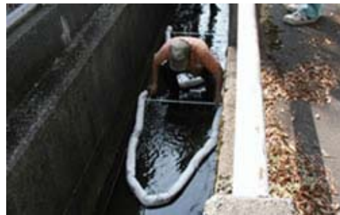
長岡工場(新潟県)にて、重油が漏洩したケースを想定し、対応手順・対策キットの作業性などを検証
