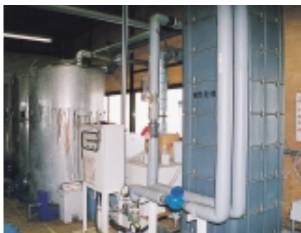
地下水浄化装置(古川工場)
