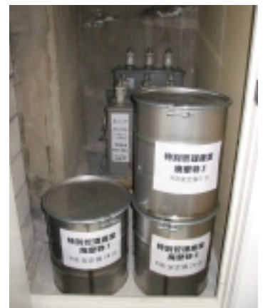
PCB保管庫(本社)
