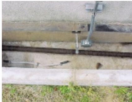
地上化した配管と漏油センサ(ペリフェラル事業部小名浜工場)
